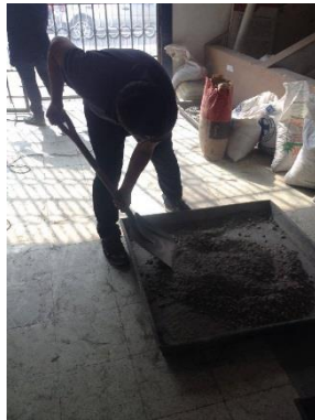
Fotografía N° 9. Mezcla de los Agregados.
