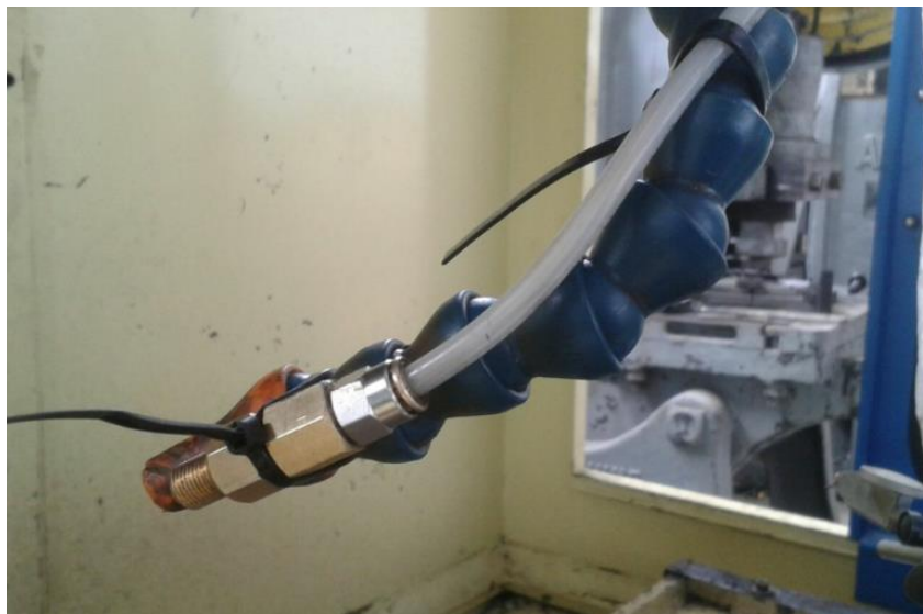
Fig. 3. 9: Anclaje del Atomizador MQL en el centro de mecanizado (Fuente: Autor)
