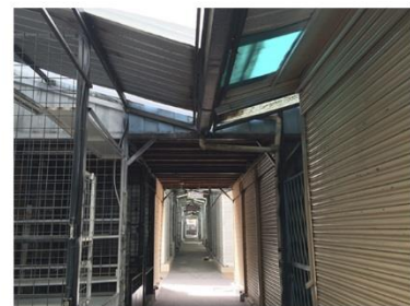
CUBIERTA ESTADO ACTUAL
