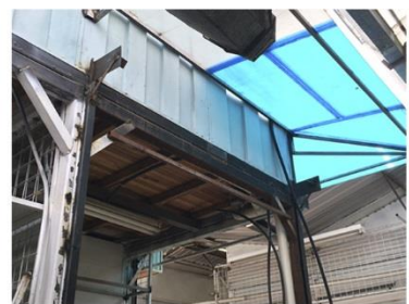
CUBIERTA ESTADO ACTUAL
