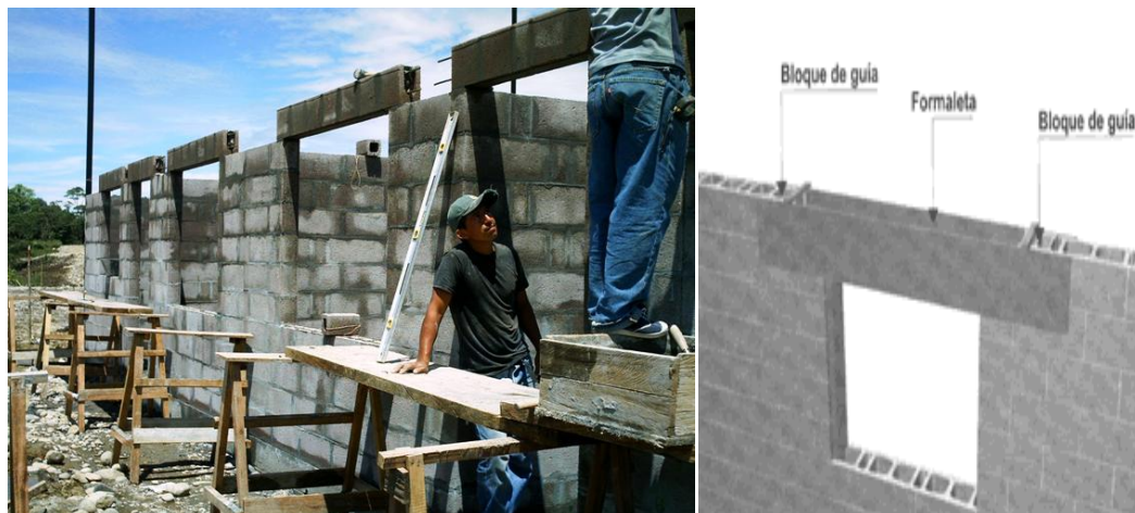
Figura 6.47 Dinteles para ventanas
