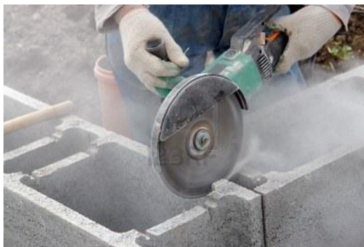
Figura 6.5 Corte de los bloques con sierra circular
