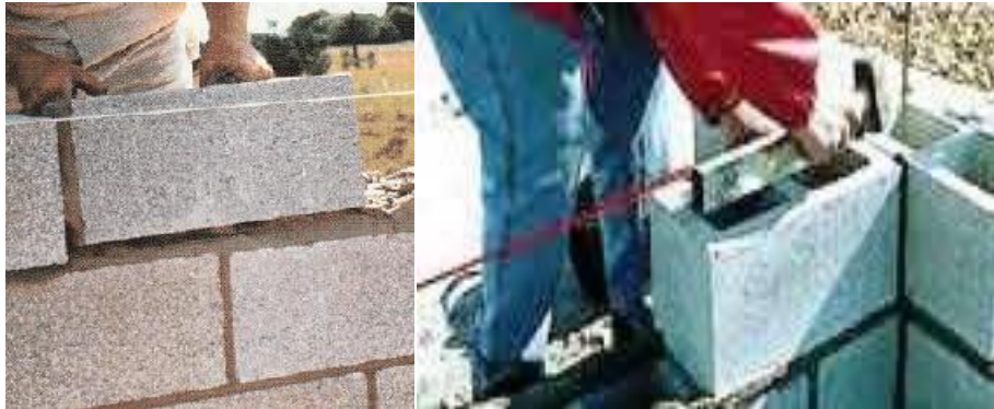
Figura 6.37 Ajuste final del bloque, presionando hacia abajo y lateralmente
