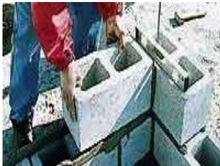
Figura 6.31 Colocación en las esquinas trabada
