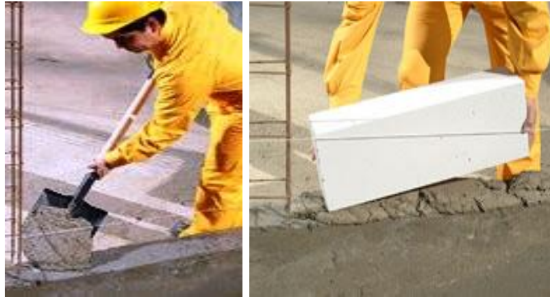
Figura 6.26 Colocación del mortero sobre el cemento
