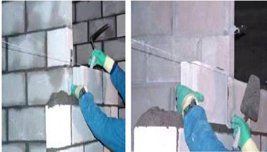
Figura 6.35 Verificación de ubicación en altura
