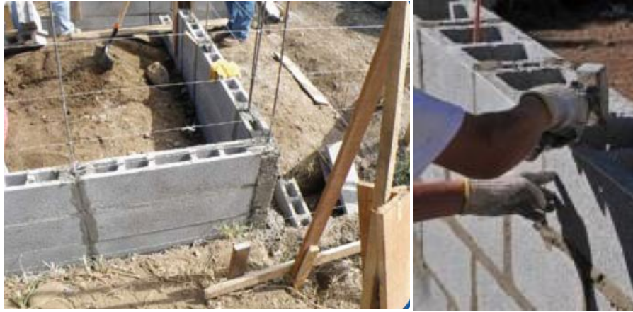
Figura 6.32 Colocación y medición de las siguientes hiladas
