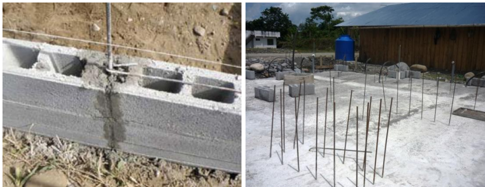
Figura 6.14 Refuerzo vertical desde la fundación
