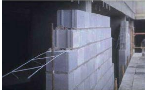
Figura 6.18 Colocación del refuerzo horizontal en las diferentes hiladas.
