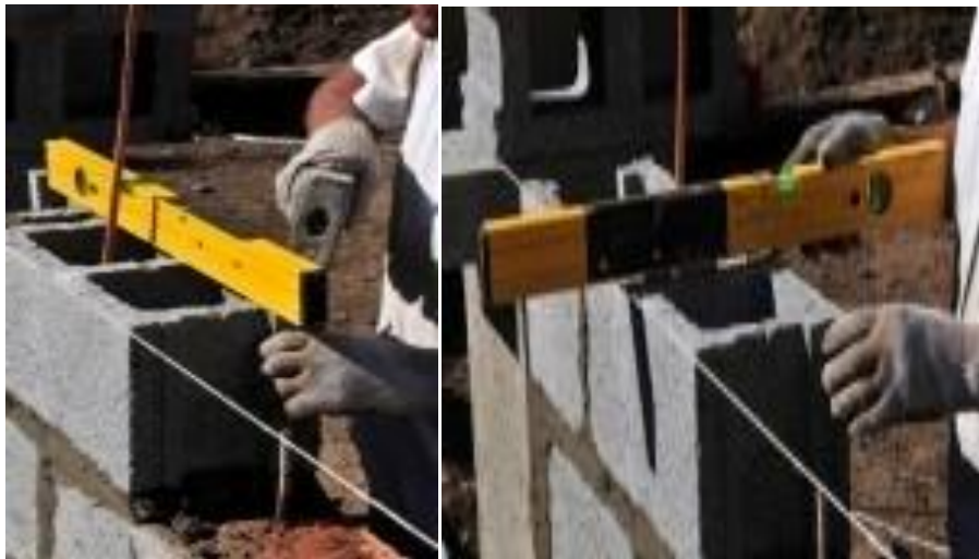
Figura 6.29 Verificación del alineamiento
