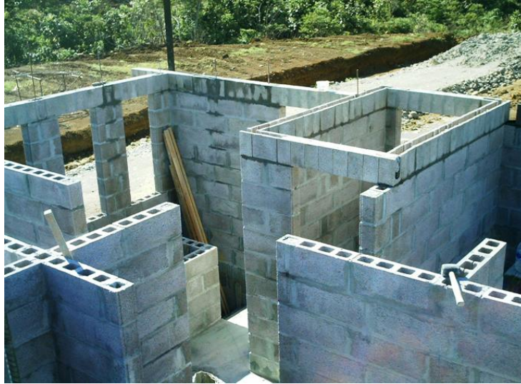
Figura 6.46 Colocación de la viga de amarre sobre los bloques
