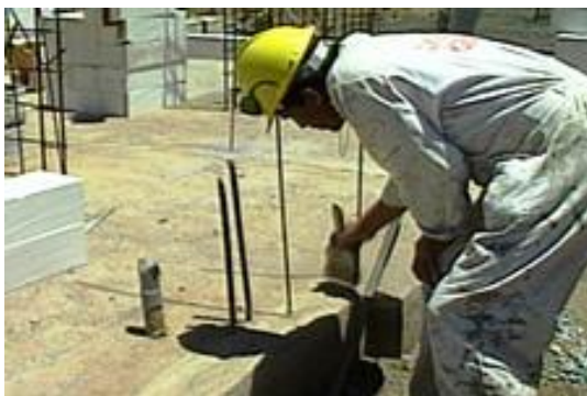
Figura 6.24 Impermeabilización del cimiento
