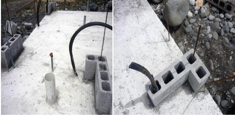
Figura 6.40 Instalaciones desde la fundación
