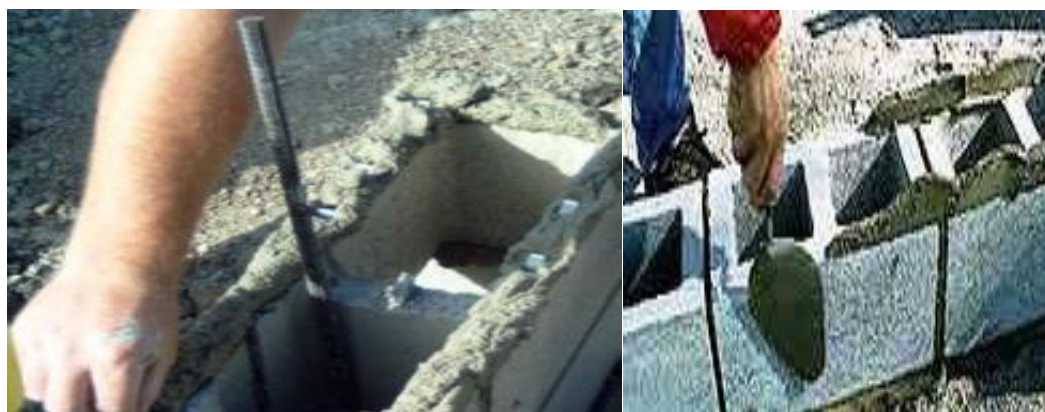
Figura 6. 36 Colocación de mortero sobre las salientes o extremos de los bloques
