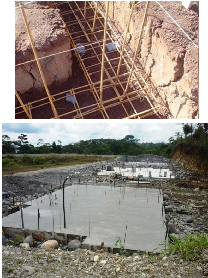
Figura 6.6 Fundación de la vivienda
