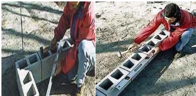
Figura 6.27 Ubicación de las esquinas y colocación de las unidades siguientes
