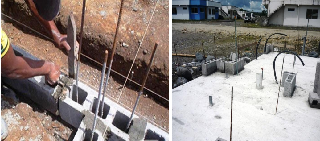
Figura 6.28 Colocación definitiva de los madrinos
