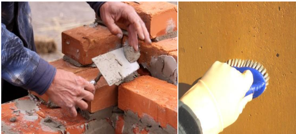
Figura 6.48 Limpieza del muro
