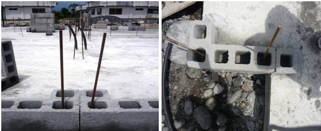
Figura 6.25 Prueba de calce de bloques sin mortero
