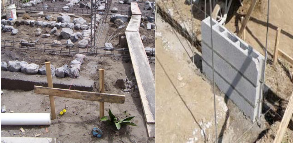
Figura 6.7 Línea de referencia para los bloques
