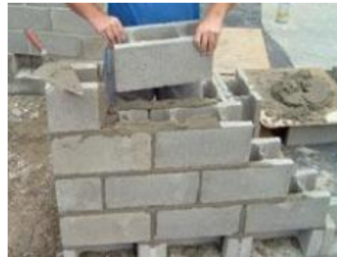
Figura 6.31 Colocación en las esquinas trabada
