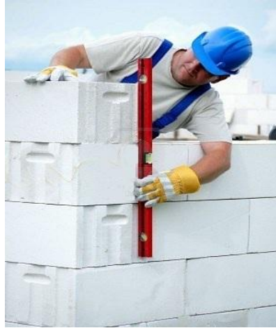
Figura 6.30 Verificación de la verticalidad y planitud.
