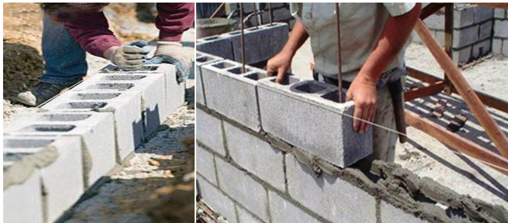
Figura 6.34 Colocación de unidades intermedias
