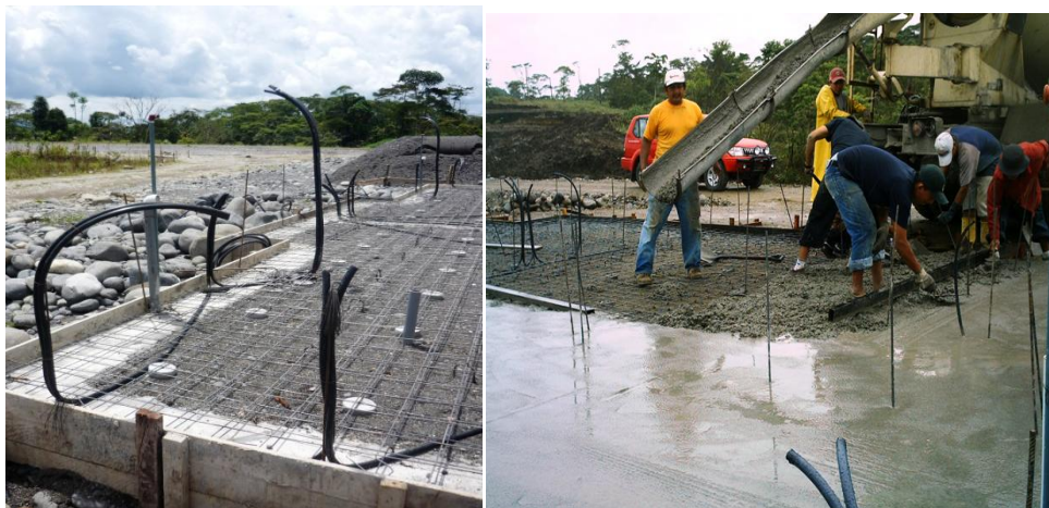
Figura 6.8 Fundación con el acero de refuerzo revisado
