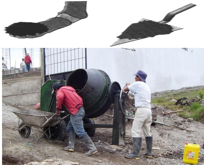
Figura 6.22 Inspección de la trabajabilidad del mortero
