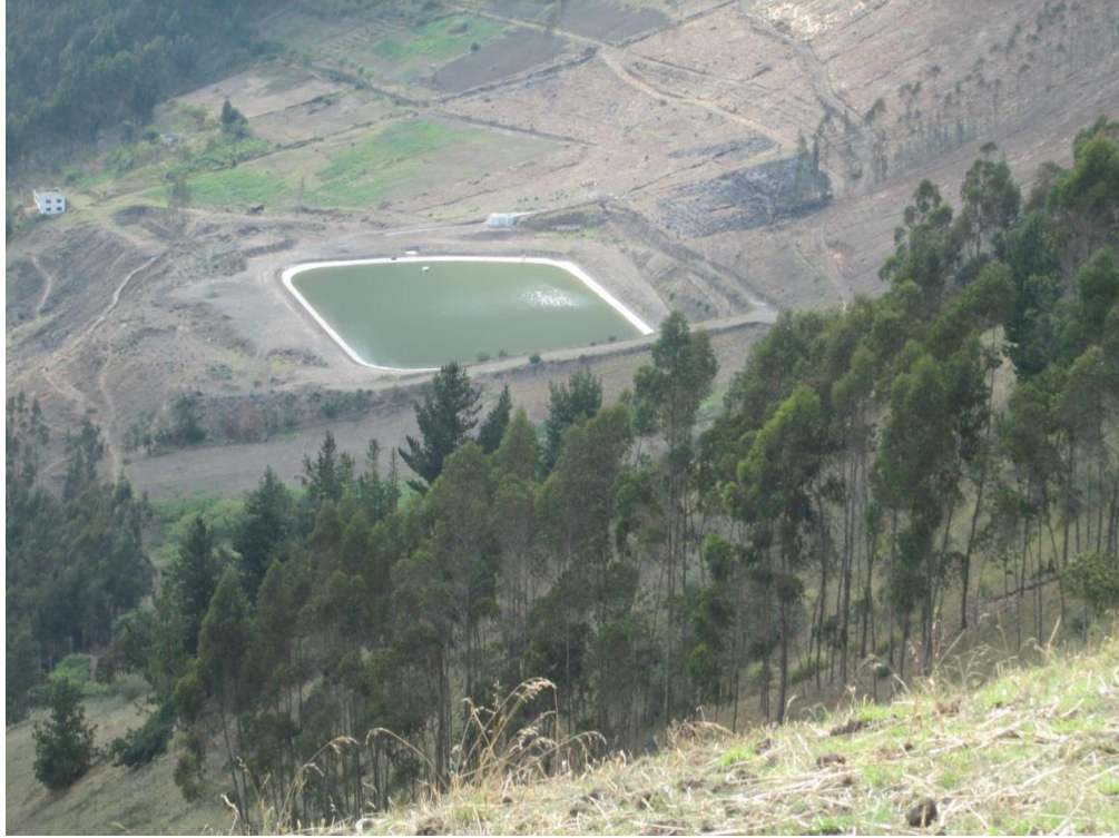
Fotografía 3. Reservorio en la parte más alta de Pasa
