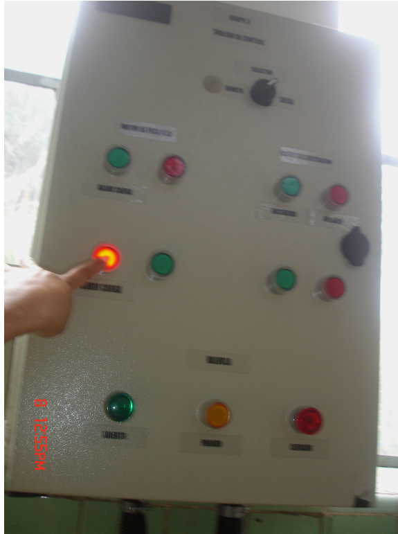
ANEXO 29. Accionamiento del motor de paso fino del Grupo # 3
