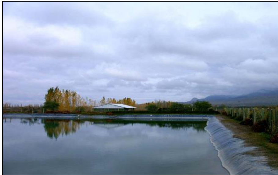
Figura 2.8 Reservorio de agua
