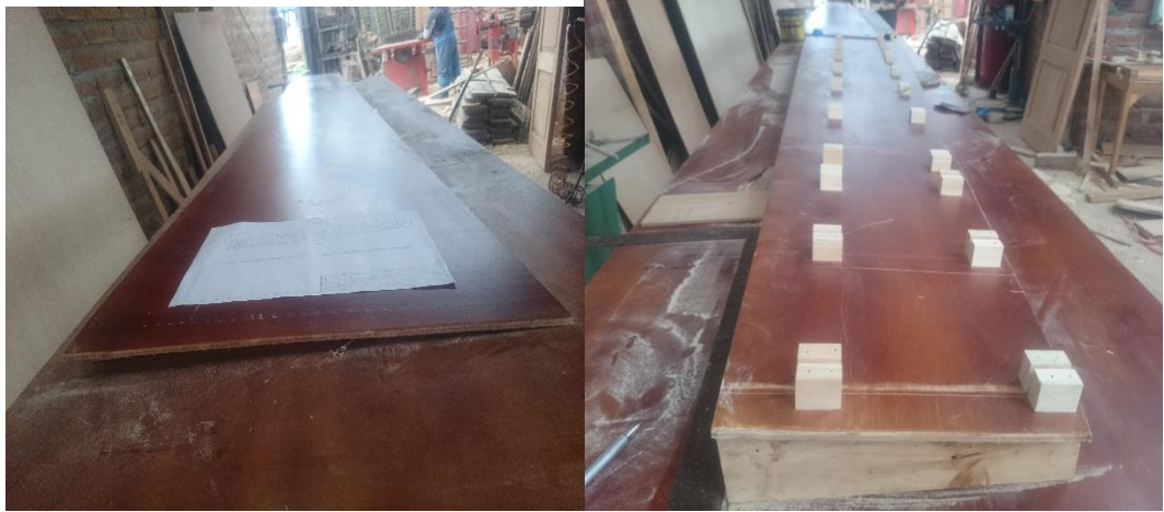
Figura 6.13.- Construcción del Jig en el taller, Fuente: autor
