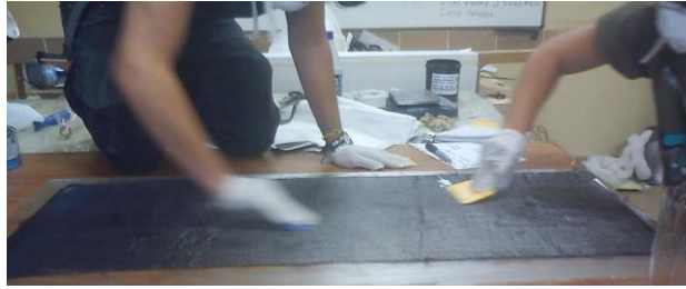
Figura 2.6.- Proceso de construcción de las costillas (GUTIERREZ, GARCIA, RODRIGUEZ, & AYALA, 2011)
