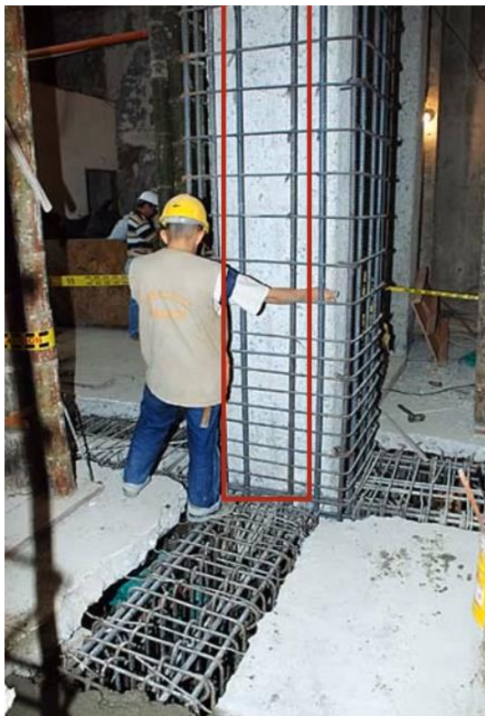
Gráfico N° 17: Armado de Encamisado de Hormigón
