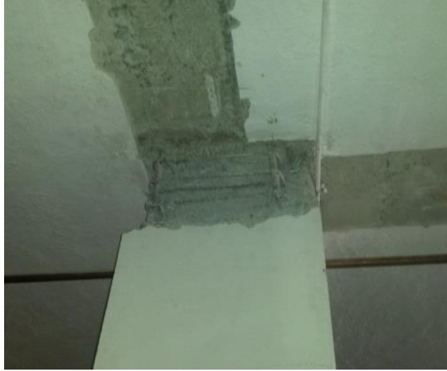
Gráfico N° 6: Unión entre Columna y Losa.
