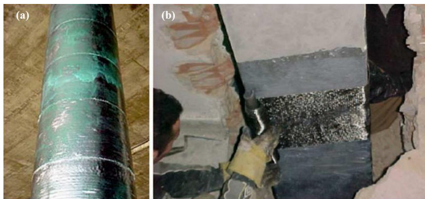
Gráfico N° 25: Refuerzo con el Sistema FRP
