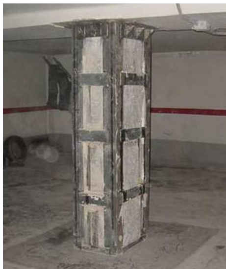
Gráfico N° 24: Reforzamiento con Pletinas Metálicas
