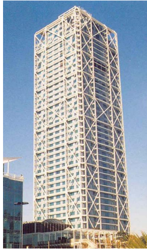
Gráfico N° 13: Edificio con Arriostramiento Metálico
