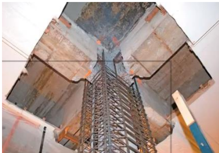
Gráfico N° 21: Armado Final para Encamisado
