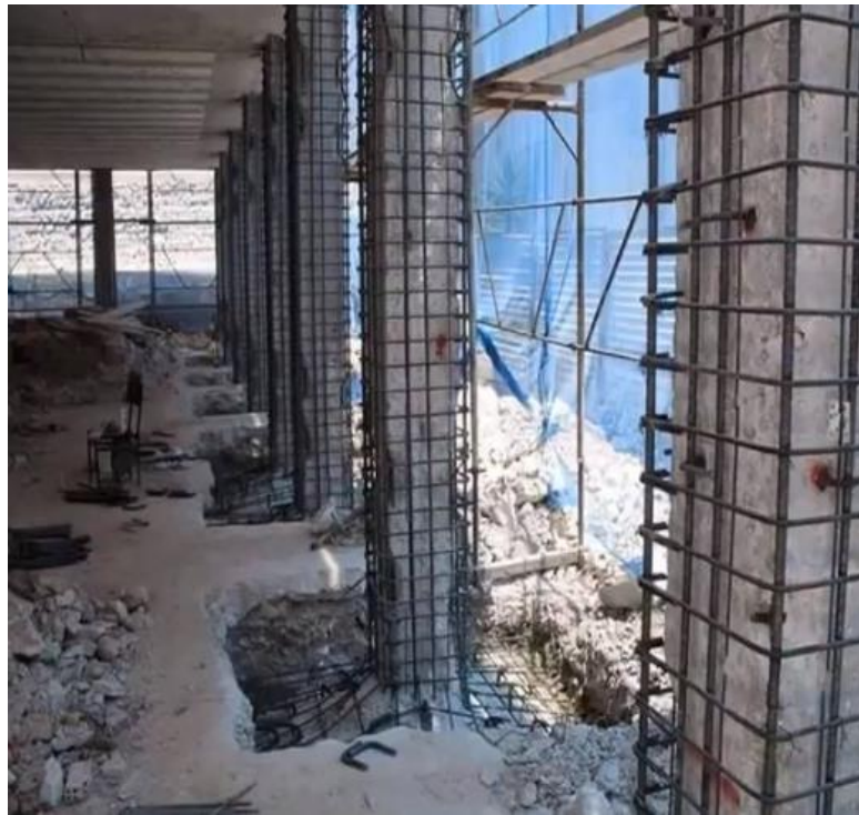
Gráfico N° 22: Encamisado de Columnas
