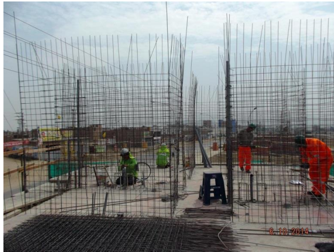
Gráfico N° 16: Armado de Muros de Ductilidad limitada
