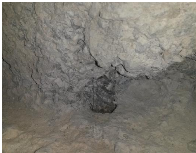
Gráfico N° 7: Unión entre Acero Principal de Columna y Hormigón de Losa.
