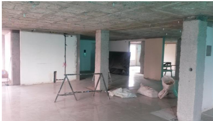
Gráfico N° 10: Losa Alivianada bidireccional de Hormigón Armado.
