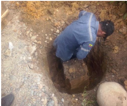
Excavación de la muestra inalterada – Km 4 + 000
