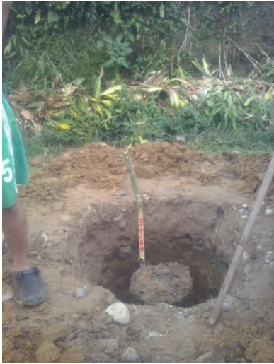
Excavación de la muestra inalterada – Km 3 + 000
