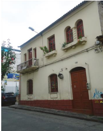
Figura 6.15 Edificación actual Fuente: Archivo digital WLT
