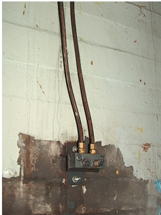
Líneas en la tubería de cobre
