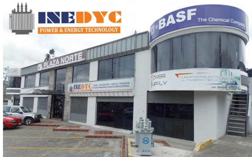
Figura 4.1: Edificio de INEDYC Fuente: Sitio web de la empresa www.inedyc.com
