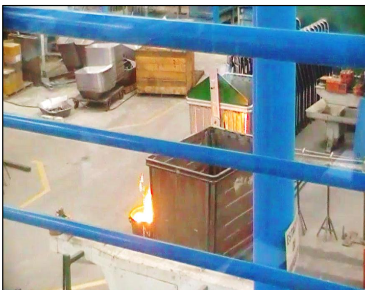
Fig. 36. Conato de incendio
