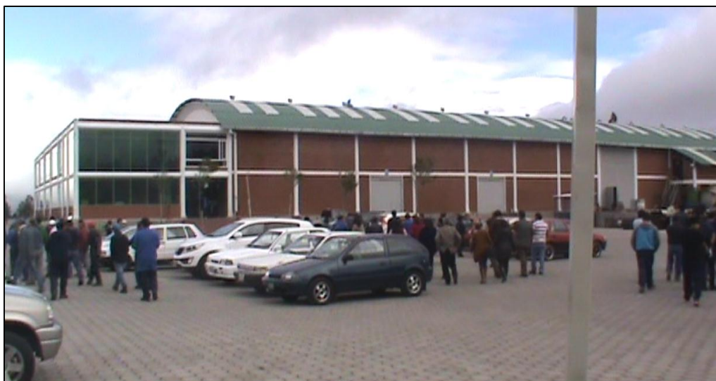
Fig. 43. Finalización de la emergencia de incendio
