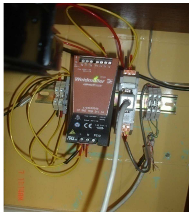
ANEXO 16. Convertidor de RS-485.
