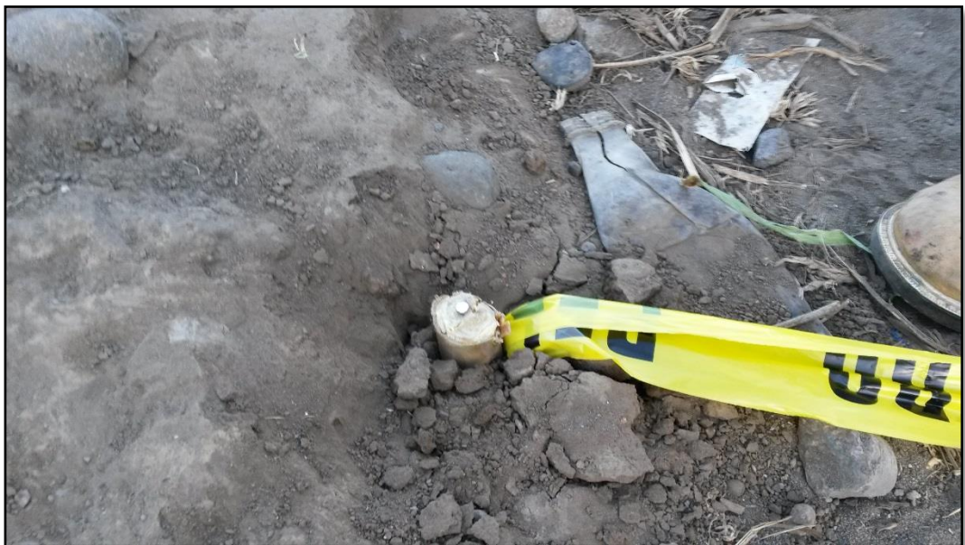
Fotografía 16: Colocación de estacas en las auxiliares.
