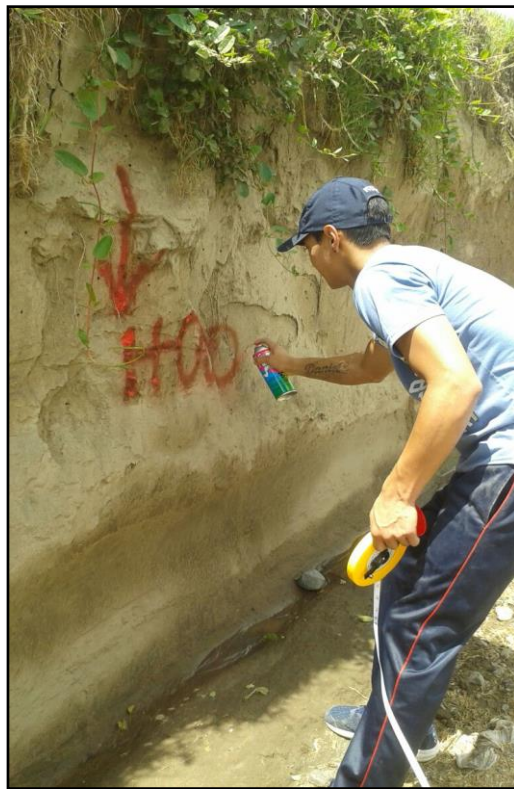
Fotografía 2: Abscisado de la vía.
