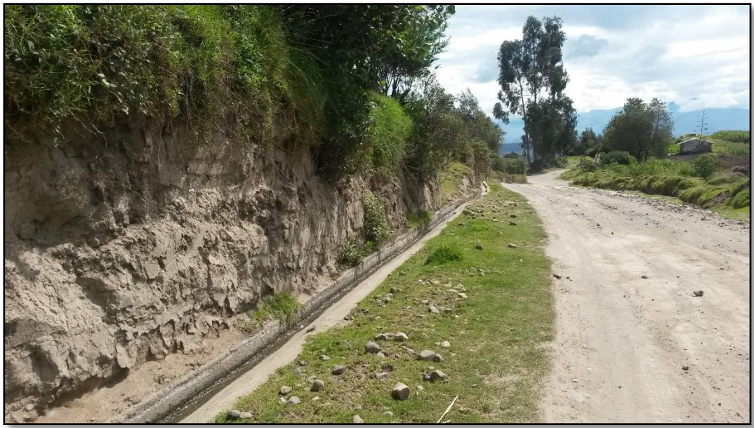
Fotografía 13: Canales de Agua de riego.
