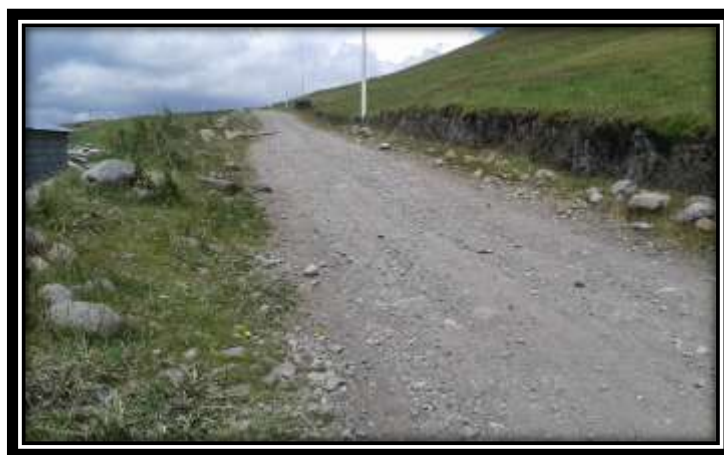
Imagen 4.- La vía lastrada permanece en constante desgaste.
