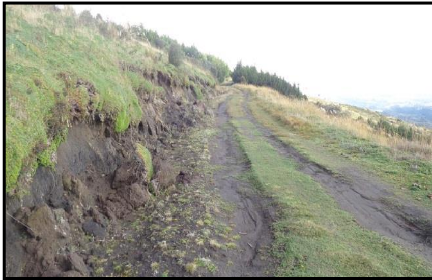
N°1: Condición actual de la vía
