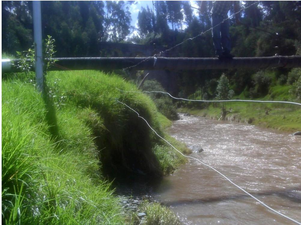
**PASO ELEVADO DE LA LÍNEA DE CONDUCCIÓN DE AGUA POTABLE CON SOCAVACIÓN VISIBLE.**
