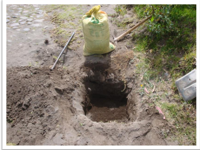
Pozo a Cielo Abierto (PCA) Km 1+000
