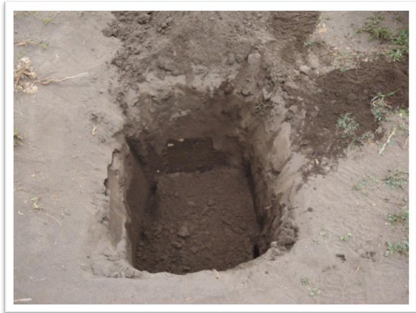
Pozo a Cielo Abierto (PCA) Km 4+000
