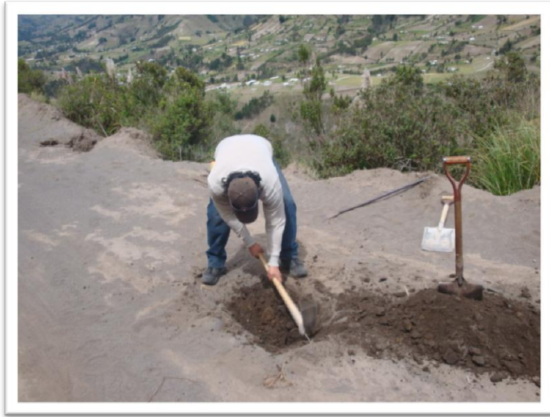
Pozo a Cielo Abierto (PCA) Km 2+000
