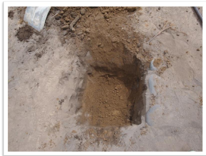
Pozo a Cielo Abierto (PCA) Km 3+000
