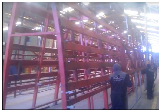
Figura 30. Traslado de estructura con grúa pórtico Fuente: Jorge Guerra (Autor)
