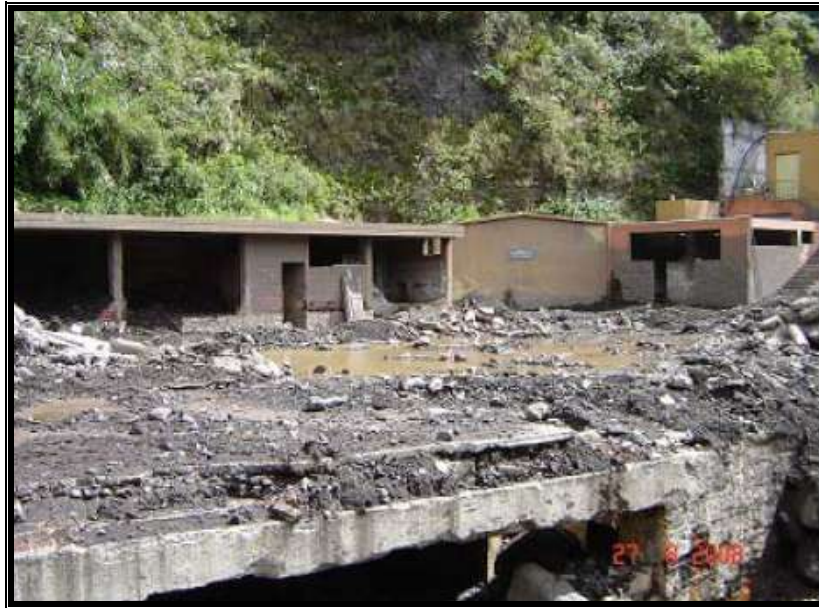
Fig. 9.- Destrucción del balneario El Salado - 2008
