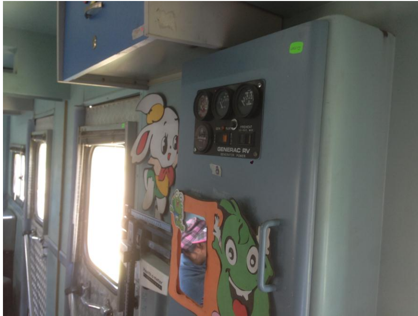
Fotografía N. 12. Caja de Breakers.
