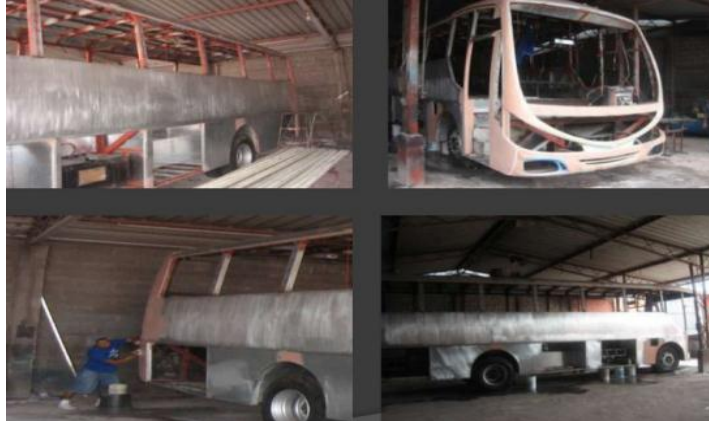
Fotografías 3: Ensamblaje básico de un bus (armado estructura) Autor: Vinicio Unda
