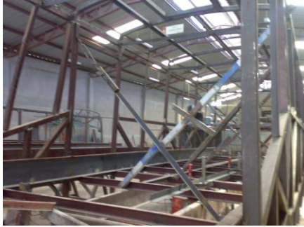
CONSTRUCCIÓN DE ESTRUCTURA
