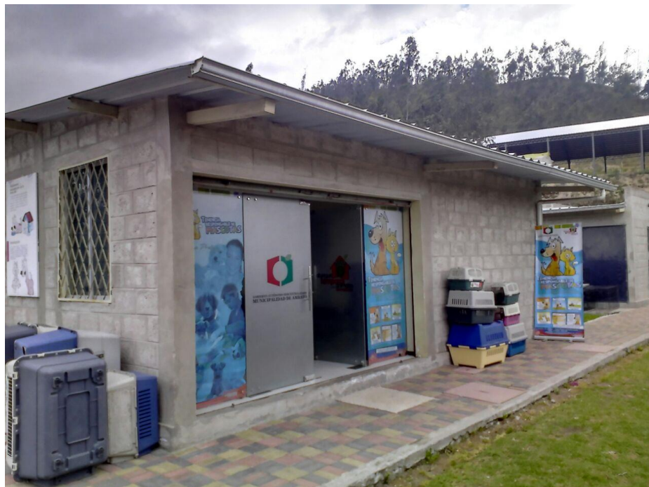
ANEXO 25: Vista lateral actual del Albergue
