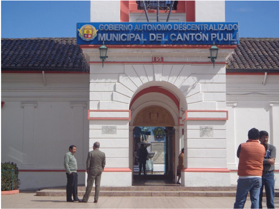
Fachada principal del G.A.D. del Cantón Pujilí
