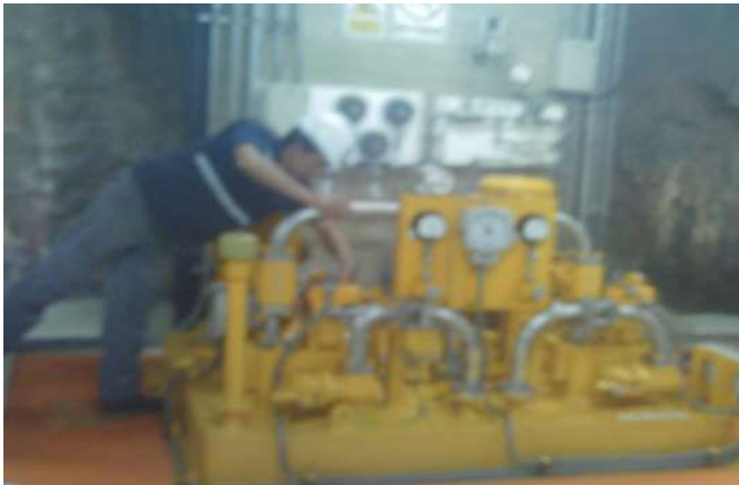
CASA DE MÁQUINAS MANTENIMIENTO
