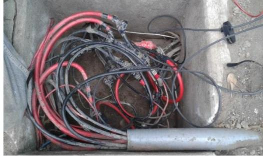
a.- Limpieza del pozo e instalación de los terminales del analizador de redes.
