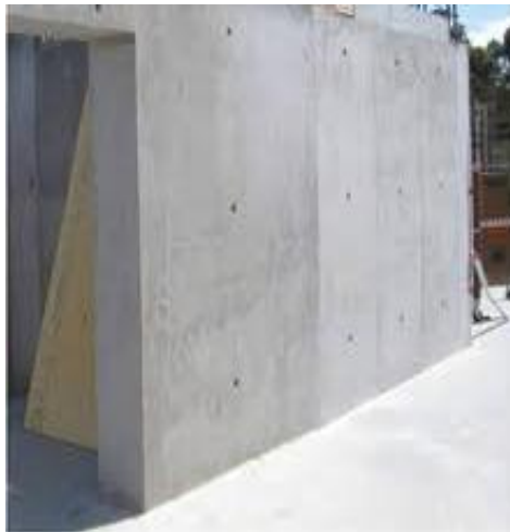
GRÁFICO N.-5 Pared 100% de hormigón de baja densidad Libre de humedad y moho.
