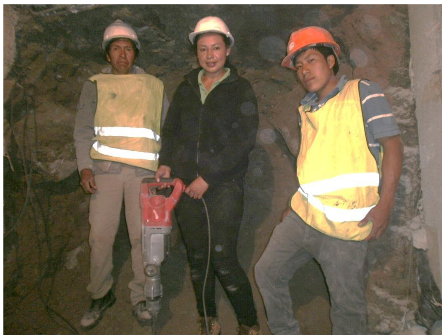
La excavación se ejecutó con personal calificado.
