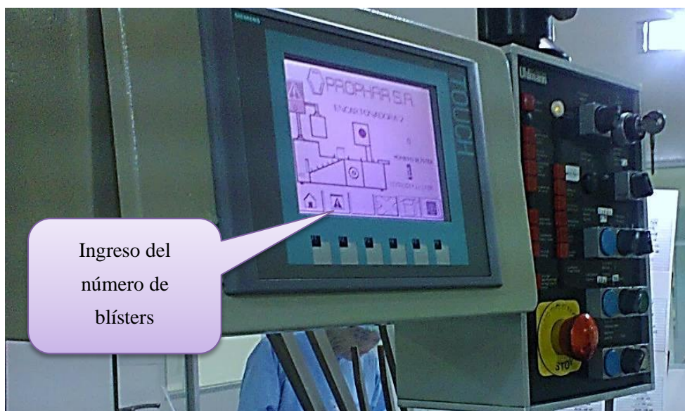
Figura 161. Arranque del panel de operador.
