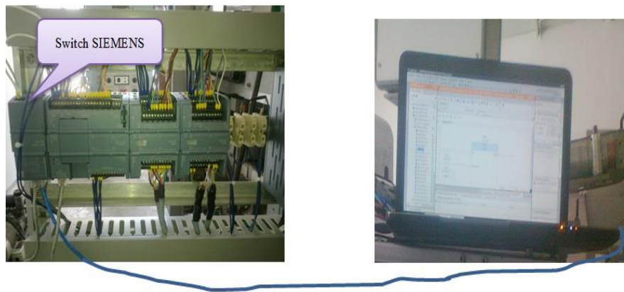
Figura 164. Conexión entre los dispositivos para el ingreso al servidor.
