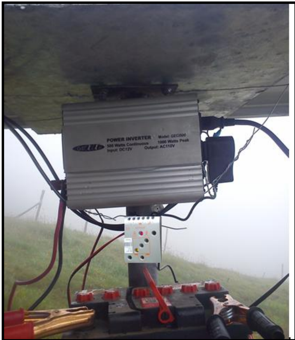
Figura 4.49 Conexión del panel solar
