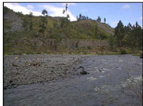
Cantera para material de empedrado
