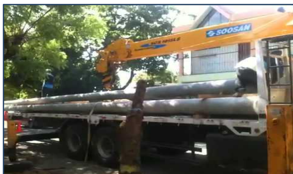
Figura 8 Camión grúa pluma descargando postes eléctricos
