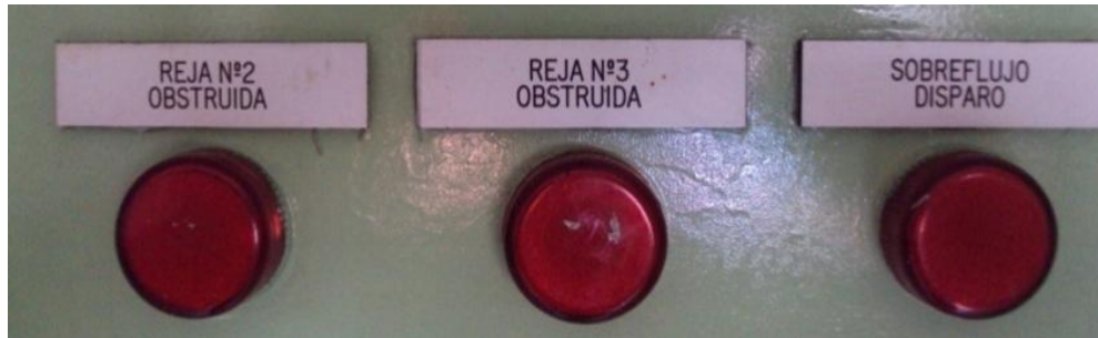
Figura 4.49: Lámparas indicadoras de rejillas obstruidas
