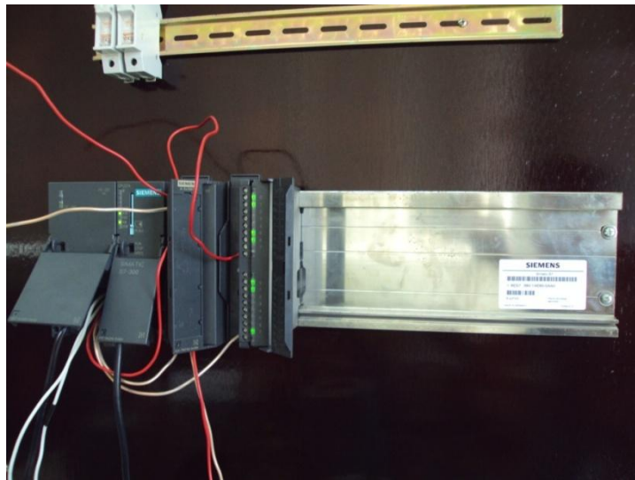
Figura 4.42: Montaje de los módulos del S7-300
