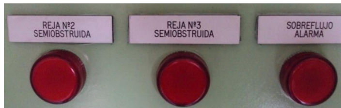
Figura 4.48: Lámparas indicadoras de rejillas semiobstruidas
