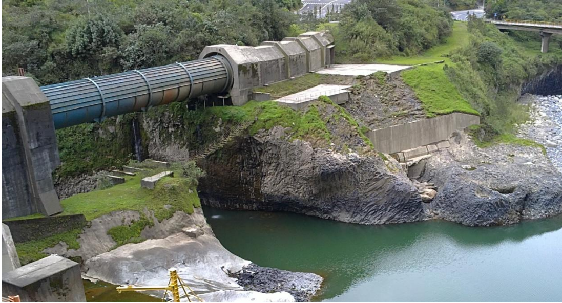
Figura 2.7: Obra de Toma
