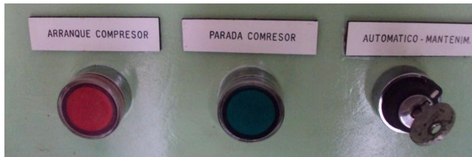
Figura 4.50: Lámparas indicadoras de arranque y parada del compresor
