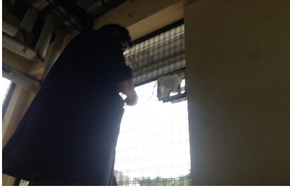
Instalación de los extractores
