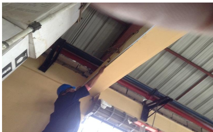
Foto 6.4 Instalación de las canaletas (Fuente: Egdo. César Robalino)
