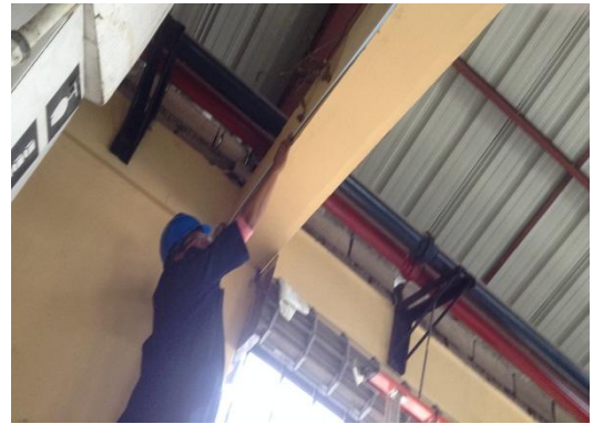
Colocación de la canaleta
