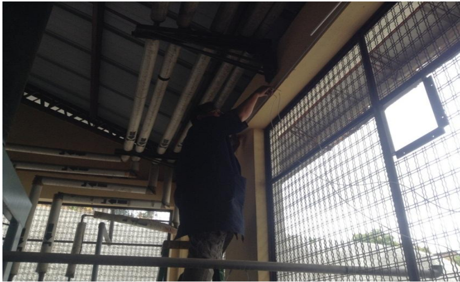
Foto 6.5 Instalación del cableado (Fuente: Egado. César Robalino)
