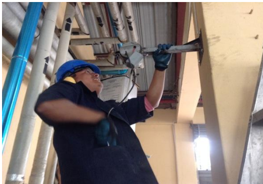
Instalación del ventilador
