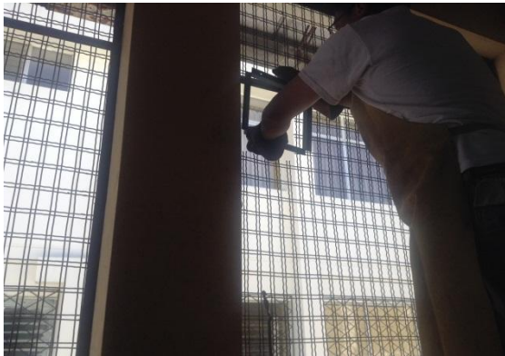
Colocación del marco
