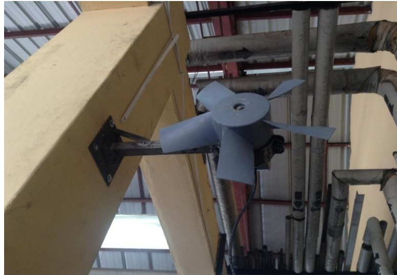
Foto 6.3 Instalación del ventilador para la mezcla de aire (Fuente: Egdo. César Robalino)
