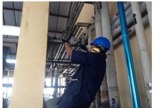
Instalación soporte del motor
