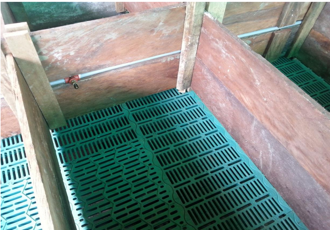
Anexo 16. Fotografía 3 (Instalación de bebederos)
