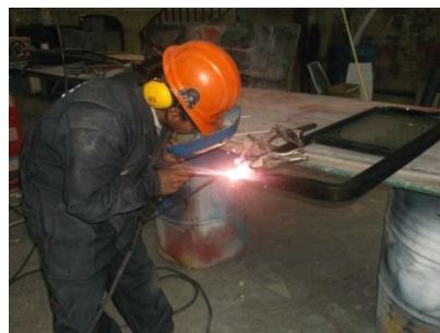
Figura 6.14 Colocación de correderas.
