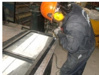
Figura 6.16 Pulido de la soldadura.
