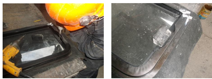
Figura 6.17 Colocación de accesorios, masillado y pintura.
