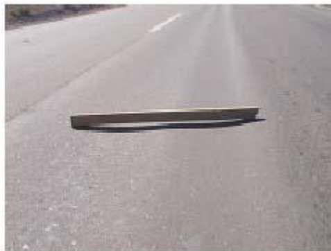
Figura 20. Ahuellamientos
