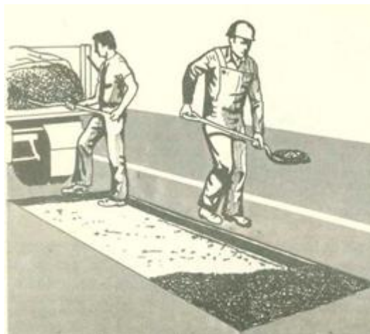
Figura 16. Colocación de la mezcla
