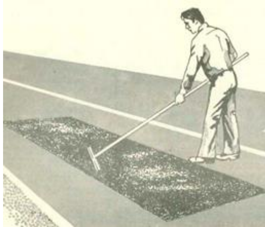
Figura 17. Extensión de la mezcla
