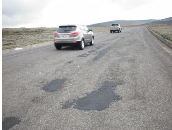
Bacheo ejecutado por administración directa.
