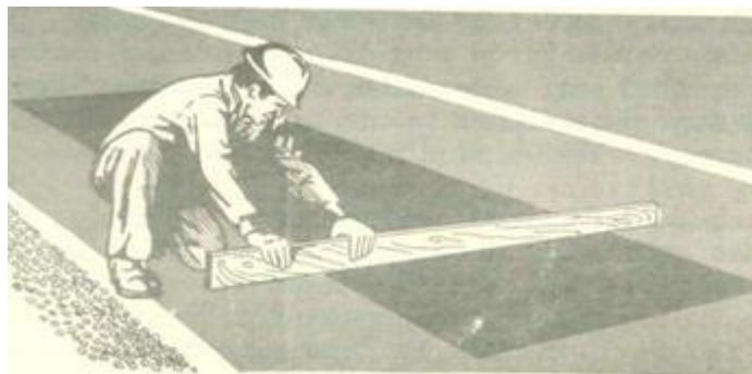
Figura 19. Nivelación o perfilamiento
