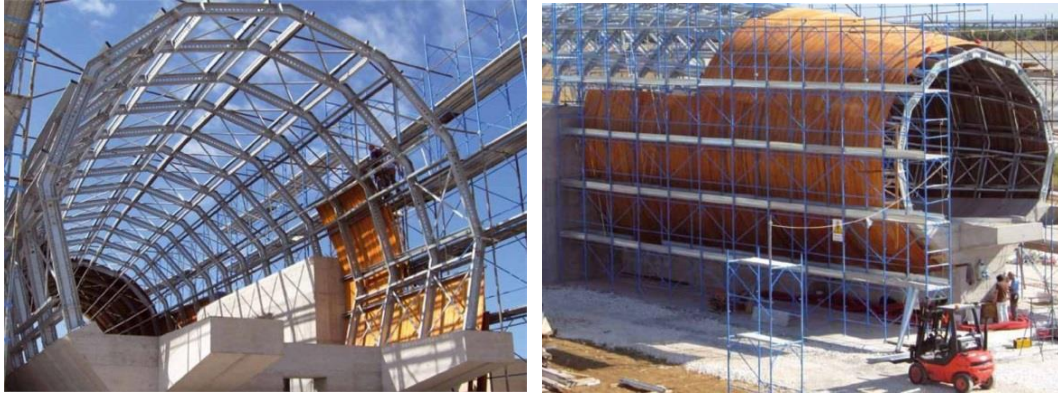
Figura. 2.4.6.1.2. Estructura reticular [36]: structura costruire (2010), recuperado de www.archiproducts.com/es/productos/75261/viga-pilar-y-perfil-metalico-estructural-structura-costruire-scaff-system.html
