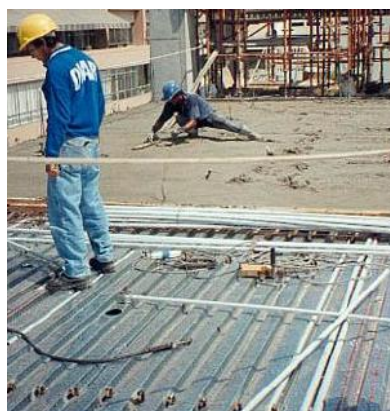
Figura 2.4.7.8.8. Vaciado de concreto
