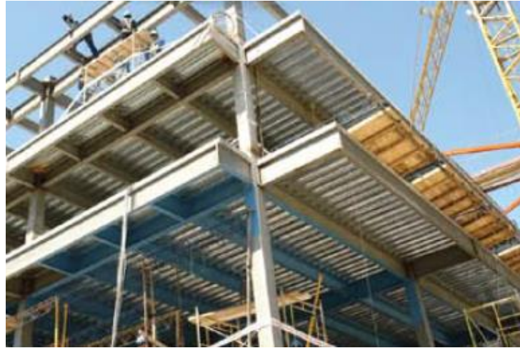
Figura 2.4.7.6.2. Detalle armado de placa colaborante
