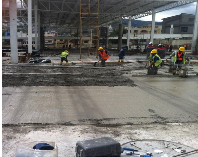
Figura No.21: Hormigonado de carpeta en Multiplaza la Merced. Elaborado por: Néstor Iza
