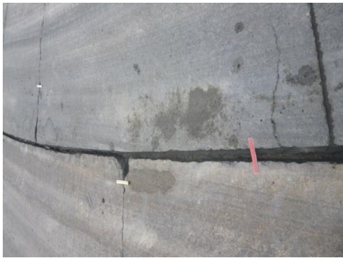
Daño de sello de juntas y losa fragmentada tramo desde la abscisa: 0+425 hasta la abscisa 0+455,41
