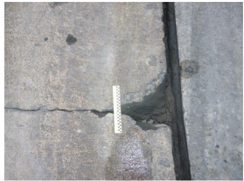
Daño de sello de juntas y losa fragmentada tramo desde la abscisa: 0+425 hasta la abscisa 0+455,41
