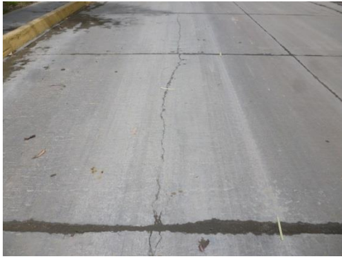
Fisura longitudinales, transversales y daño de sello de junta abscisa: 0+763
