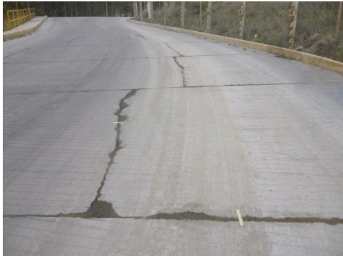
Fisuras longitudinales y daño de sello de juntas tramo desde la abscisa: 0+590 hasta la abscisa 0+609
