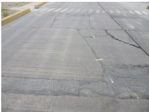
Daño de sello de juntas y losa fragmentada tramo desde la abscisa: 0+470 hasta la abscisa 0+480
