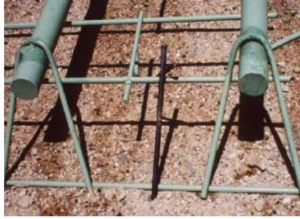
Detalle de la puesta de las barras
