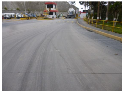
Fisura longitudinales, transversales, daño de sello de junta abscisa: 1+167
