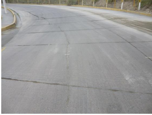
Fisuras longitudinales y daño de sello de juntas tramo desde la abscisa: 0+551 hasta la abscisa 0+580
