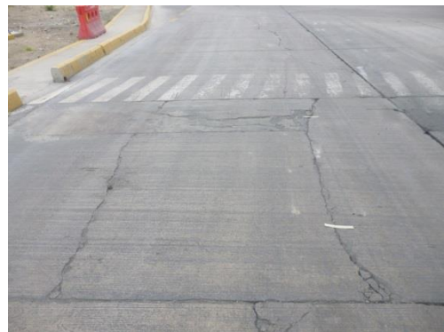
Daño de sello de juntas y losa fragmentada tramo desde la abscisa: 0+470 hasta la abscisa 0+480
