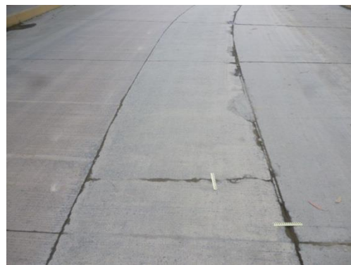
Fisura longitudinales, transversales, daño de sello de junta desprendimiento de junta abscisa: 1+110
