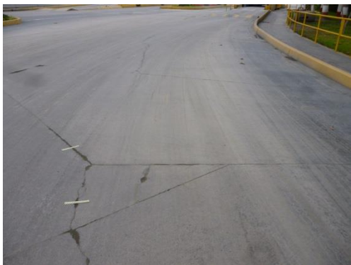
Fisura longitudinales, transversales, daño de sello de junta abscisa: 1+167
