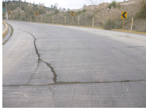
Fisuras longitudinales y daño de sello de juntas tramo desde la abscisa: 0+551 hasta la abscisa 0+580
