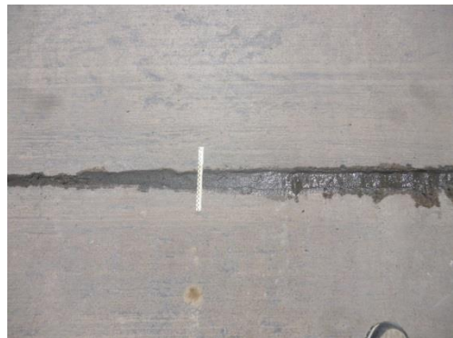
Fisura transversales y daño de sello de junta abscisa: 0+745
