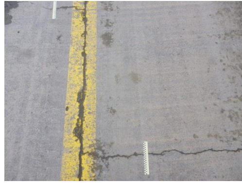
Fisura longitudinales, transversales y daño de sello de junta abscisa: 0+763
