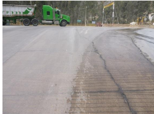
Fisuras longitudinales y daño de sello de juntas tramo desde la abscisa: 0+590 hasta la abscisa 0+609
