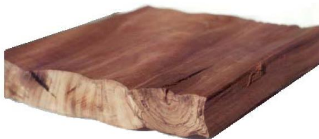
FIGURA N° 2.31. Agrietamiento interno y colapso.
