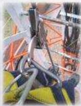
Arrestador para cable de 3/8"
