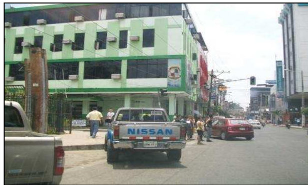
Figura 6.7: Vista hacia el Municipio de Quevedo
