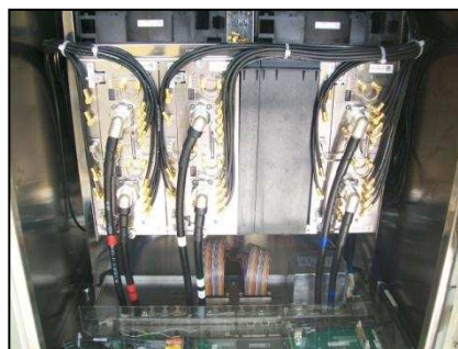
Figura 6.36: BTS y tipo de combinador
