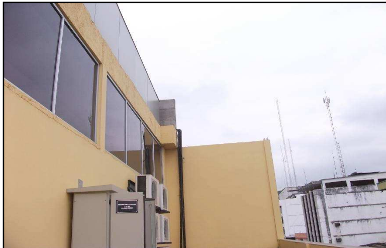
Espacio donde se colocará antena del Sector 1
