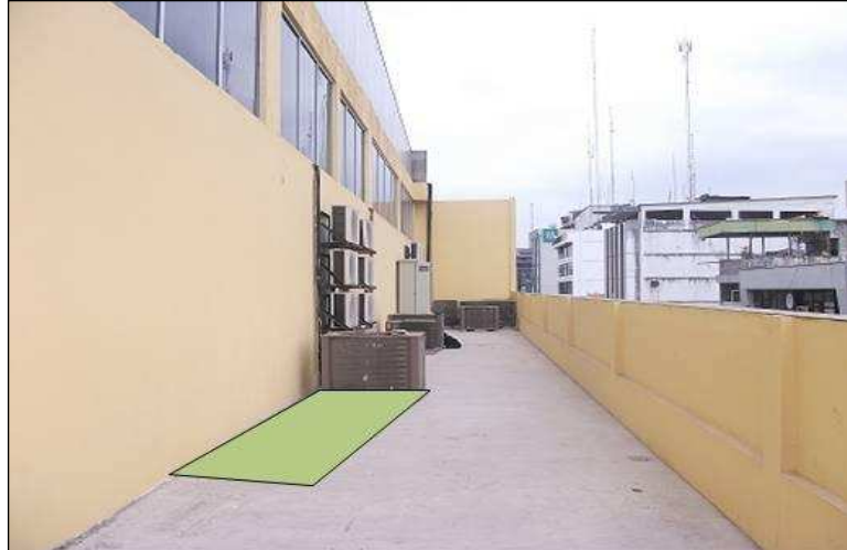
Espacio disponible para instalar los equipos.
