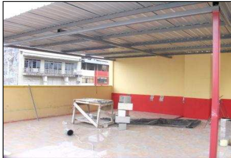
Espacio donde se colocará antena del Sector 3
