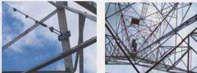
Plataformas de desplazamiento o líneas horizontales, posibilidades para asegurar los desplazamientos en torres muy anchas.
