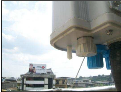
Figura 6.30: Til Eléctrico 2°
