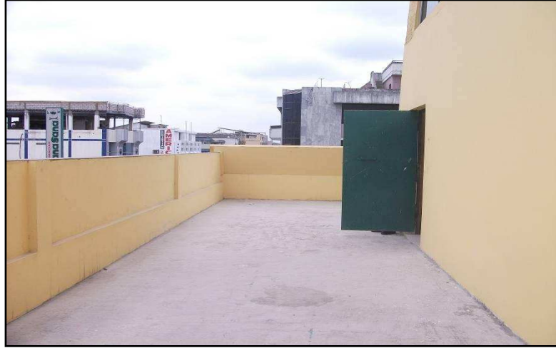
Espacio donde se colocará antena del Sector 2
