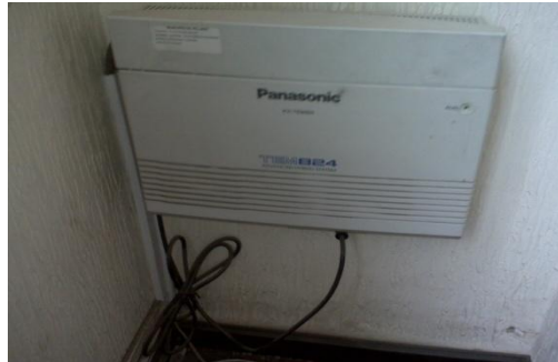
Figura 6.34 Central Telefónica KX-TEM824 Panasonic
