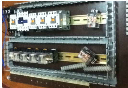
Figura 6.90. Montaje de regletas Din y canaletas perforadas
