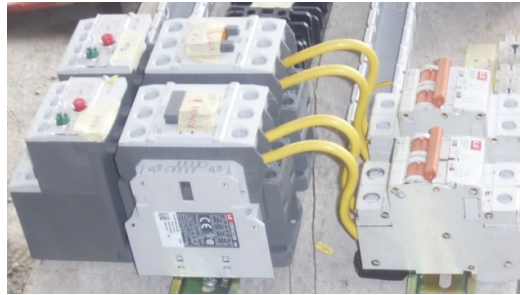
Figura 6.87. Montaje de breakers, contactores y relés térmicos
