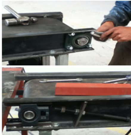
Figura 6.80. Montaje de chumaceras de pared y tensoras
