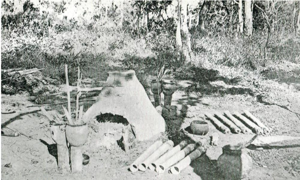
**Figura 2.5: Horno para la fundición de hierro**
