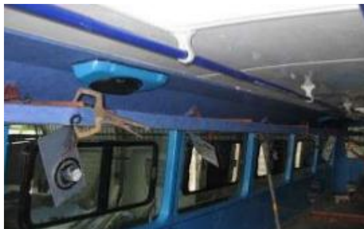
Figura N°48: Acabados finales y pintura total
