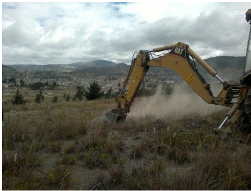
Ilustración 33: Excavación de suelo Fuente: Archivo Juan Ulloa
