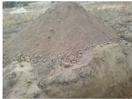
Ilustración 34: Excavación de suelo, resultado 1 Fuente: Archivo Juan Ulloa
