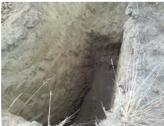
Ilustración 35: Excavación de suelo, resultado 2 Fuente: Archivo Juan Ulloa
